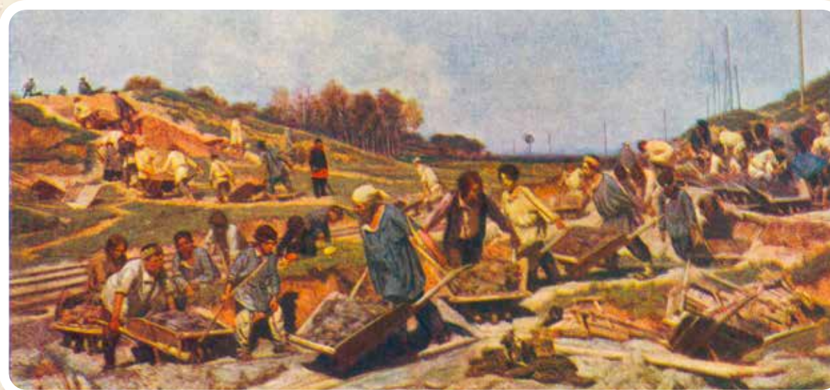
Ремонтные работы на железной дороге, 1874 г. Художник К.А. Савицкий. Почтовая открытка
