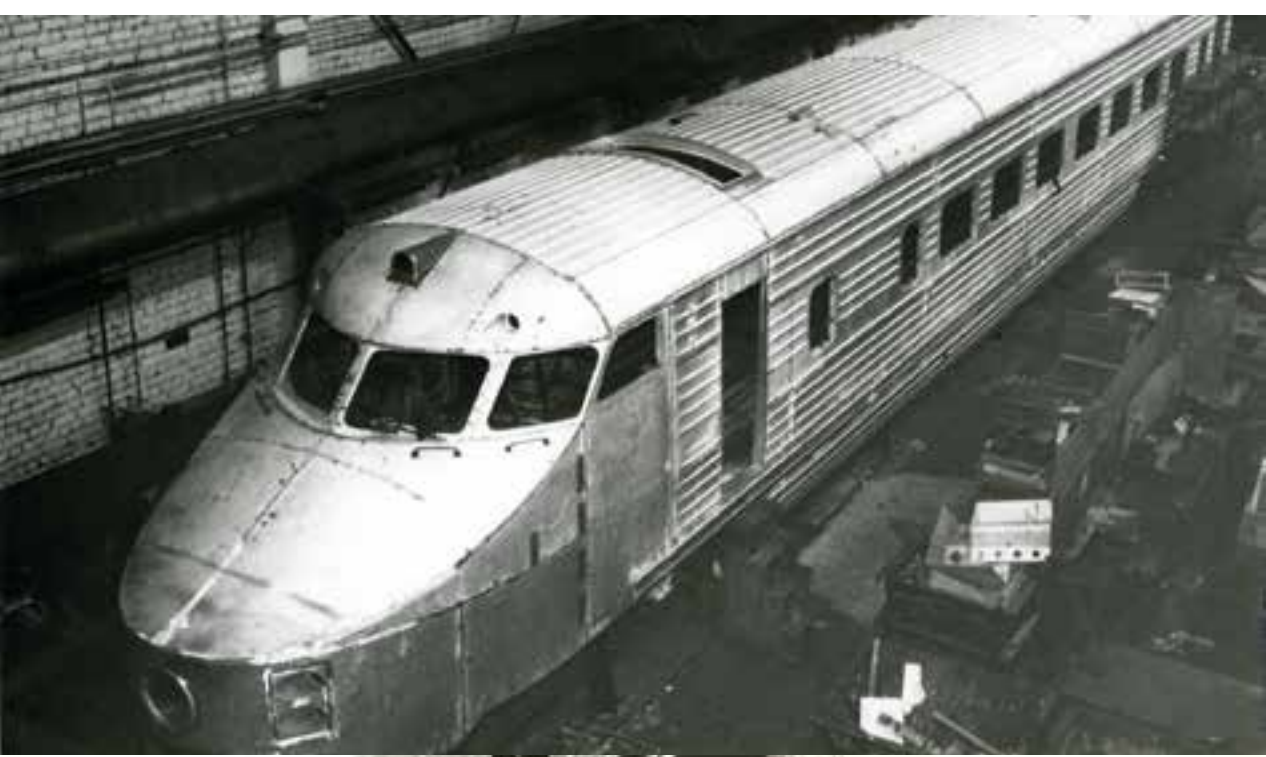
Сборка головного вагона ЭР-200 на Рижском вагоностроительном заводе. Начало 1970-х гг.
