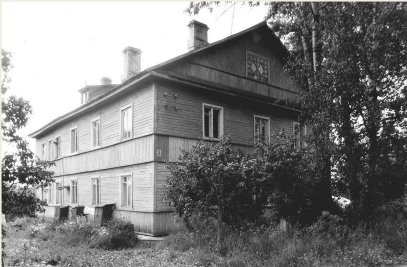
Здание бывшего сиротского дома на станции Любань 1960-е гг.
