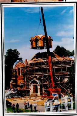
10 июля 1996 г. установлены постоянный шатер и купол, изготовленные на объединении «Ижорские заводы».
