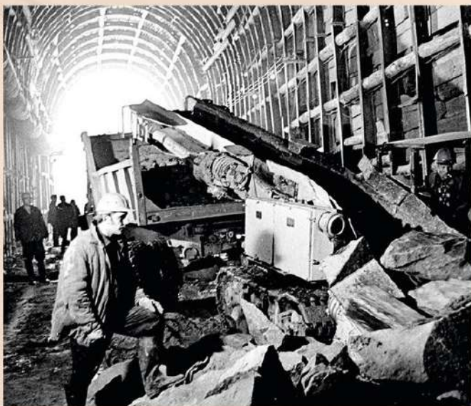
У западного портала Байкальского тоннеля. 1977 г.
