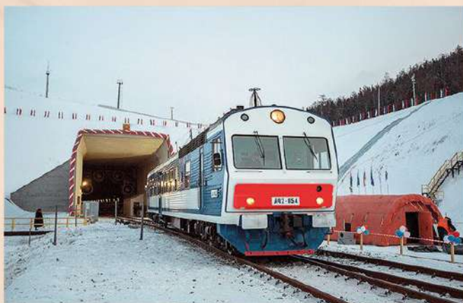
Новый Кузнецовский тоннель. 2012 г.
