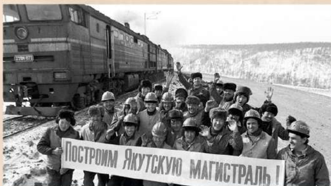
Строители Амуро-Якутской магистрали, 1970-е гг.
