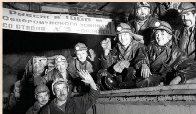
Строительство Северомуйского тоннеля. 1970-1980-е гг.
