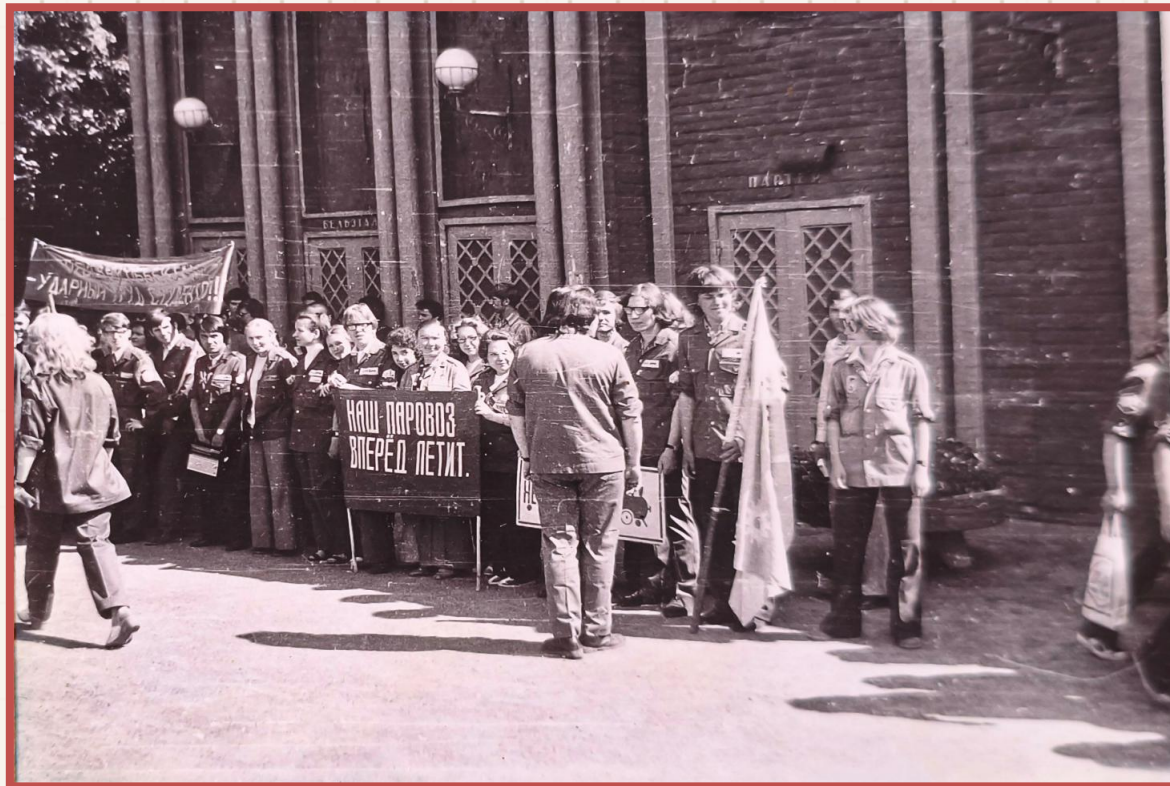
Построение перед отправкой на стройку. 1975 г.
