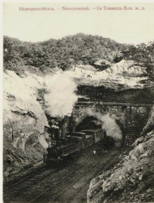
Поезд следует через тоннель около Новороссийска. Начало XX в.
